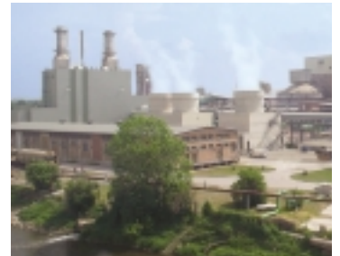
Die Energieversorgung im Solvay-Werk Bernburg soll durch das geplante EBS-Heizkraftwerk ergänzt und langfristig gesichert werden.
