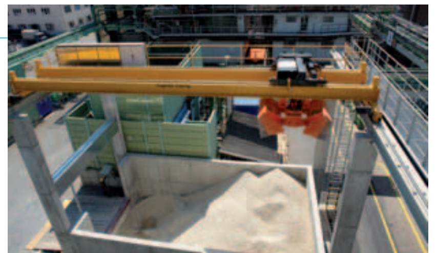
Kalksteinsplitt zur Neutralisation saurer Abwässer.
