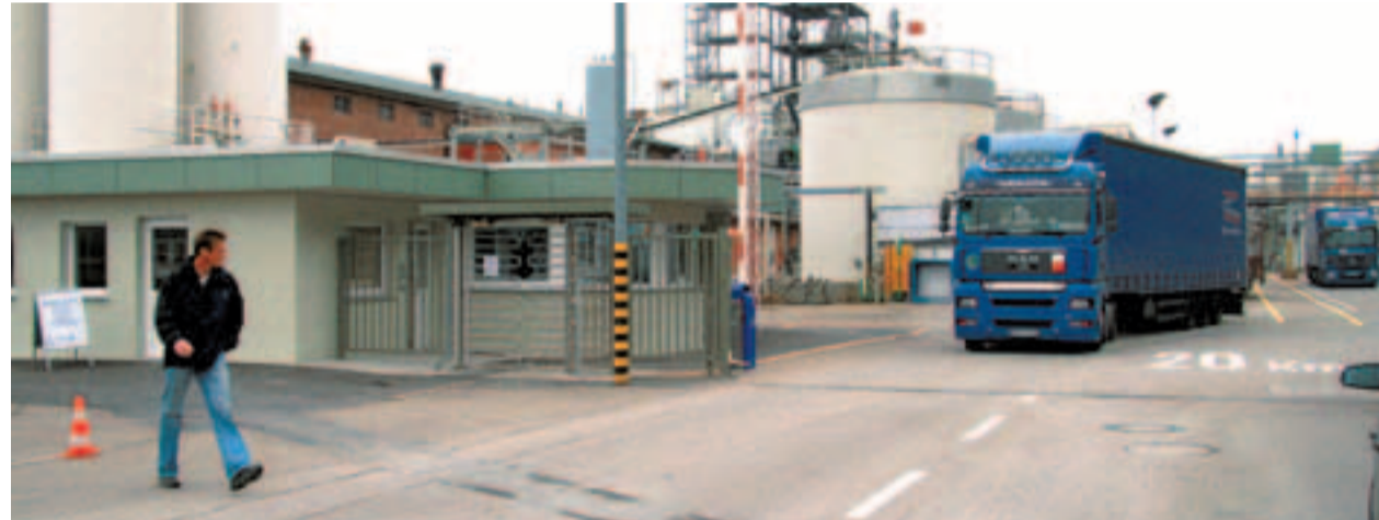
Pfortnergebäude, Schranken und Tore wurden modernisiert.
