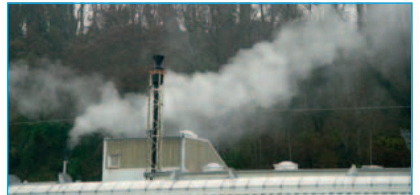
Bei kalter Winterluft bildet sich mitunter Wasserdampf beim Ausatmen. Dabei kondensiert dampfförmiges Wasser, das dann als Nebel sichtbar wird. Der gleiche Effekt lässt sich nun auch wieder bei Schornsteinen von Wohnhäusern oder bei Industrieanlagen beobachten. Im Solvay-Werk wird beispielsweise das natürliche Mineral Flussspat mit Gasbrennern getrocknet. Nach dem Filtern gelangt die warme und feuchte Luft in die Umgebung. Beim Abkühlen bildet sich dann der deutlich sichtbare Nebel.
